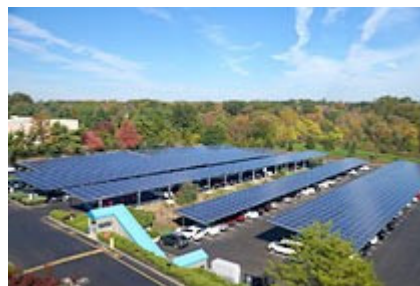
駐車場に設置した太陽光発電設備（米国）
